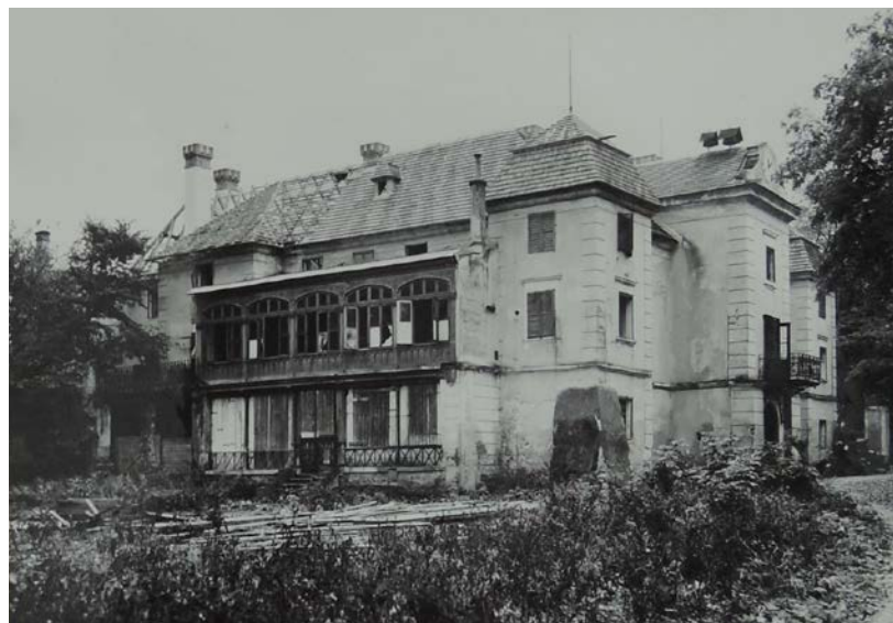
Obr. č. 3: Pohľad na kaštieľ v Brodzanoch v roku 1958. Zdroj: Archív Pamiatkového úradu v Bratislave
